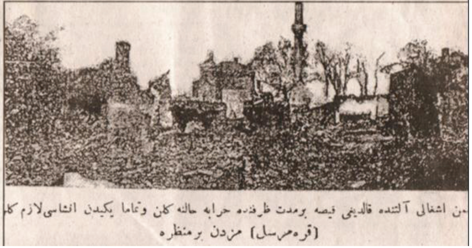
Yunanlılar tarafından yakılıp yıkılan Karamürsel'in enkaz halindeki çarşısı
